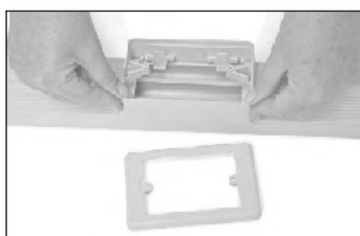
Posicione um dos lados do Porta Equipamentos na canaleta.
